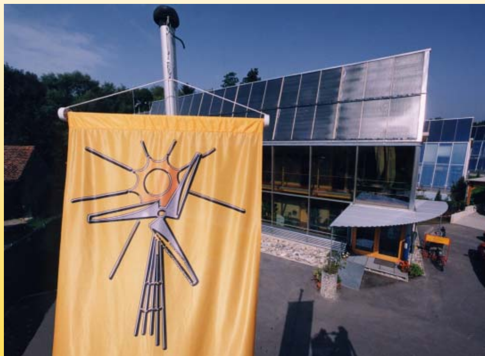
Solar unterstützte Biomassenahwärmenetze Salzburg am 5. November 2004
