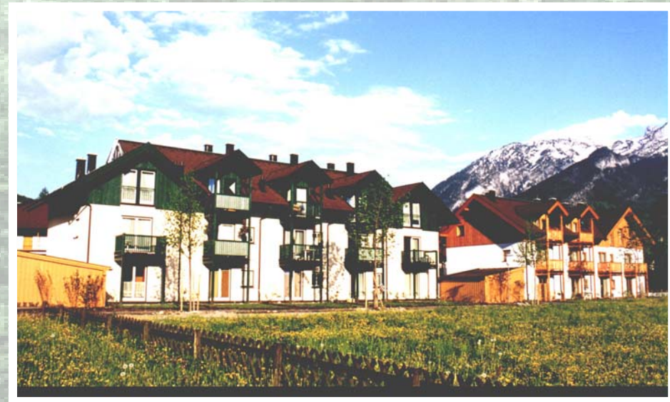
Ansicht Wohnanlage Golling „Bernhofer“
