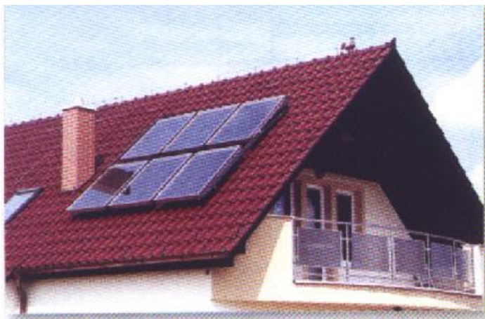
Obr. 3 Ploché kapalinové solární kolektory na držácích na šikmé střeše
