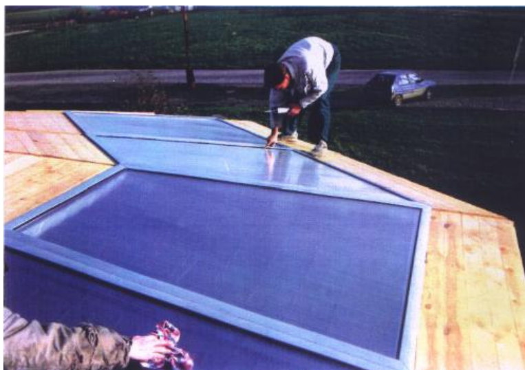
Obr. 2 Ploché kapalinové solární kolektory montované jako součást střechy oktagonálního domku
