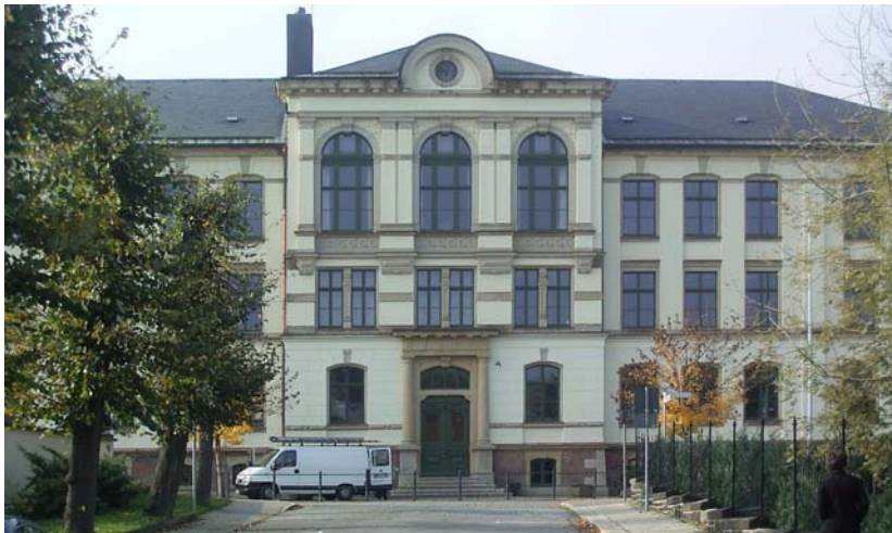
Sanierte Fassade der Mittelschule 2007
