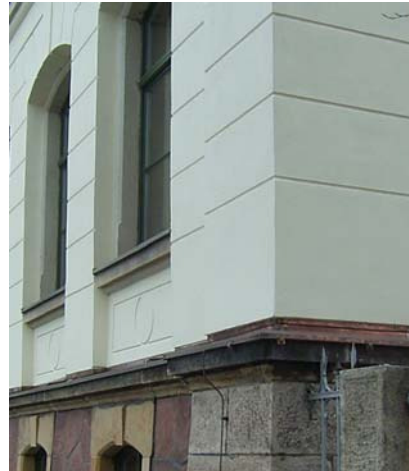
Nordost-Ecke nach Behebung der Schäden
