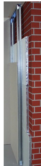
und im Wandbereich
