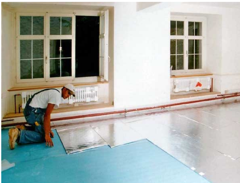
Einbau von Vakuumisolationspaneelen im Innenbereich als Fußbodendämmung...
