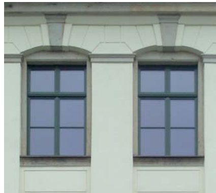
Fensterteilung nach der Sanierung
